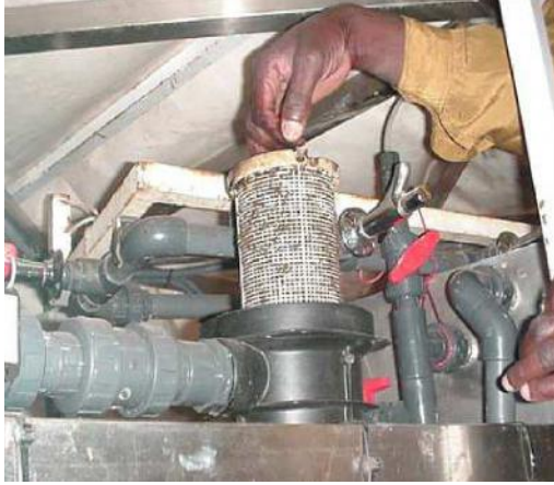
Figura 12: Limpiando el filtro de piscina (Pre - filtro)
