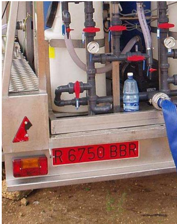
Figura 8. Vista general de la planta
