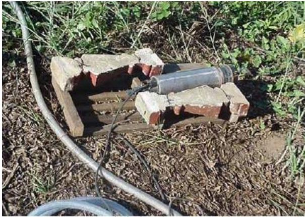
Figura 18: Protegiendo la bomba sumergible
