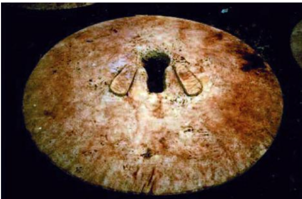
Figura 39, Capítulo 2, Manual ERU de Saneamiento, Cruz Roja Española, 2001. En este caso se trata del modelo más pequeño de tapas, aunque hay otros de forma circular que no necesitan refuerzos en el hormigón (las que equipa la ERU) y cuyo proceso de construcción con moldes es prácticamente el mismo.
