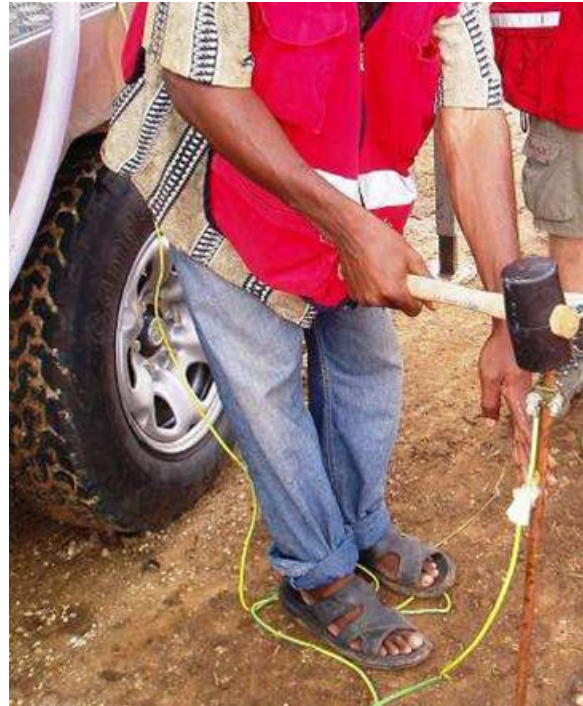
Figura 19: Instalación de la toma de tierra
