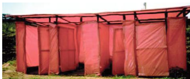
Figura 38, Capítulo 2, Manual ERU de Saneamiento, Cruz Roja Española, 2001. Letrina comunitaria hecha con cubiertas de plástico -plastic sheeting-.
